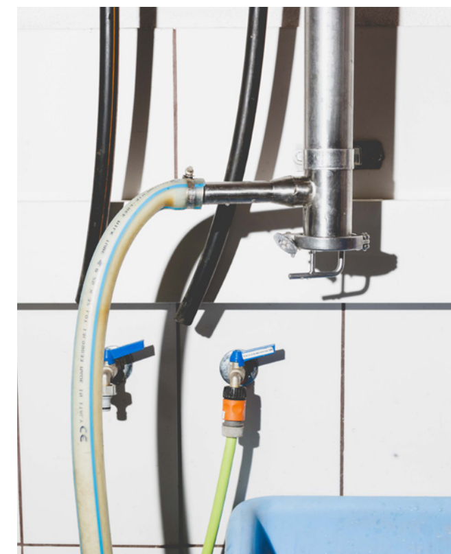
In der Melkanlage befindet sich ein Filter. → 35mm | 1/125s | f6,3 | ISO800
